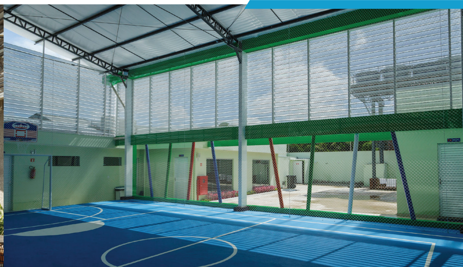
DETALHE DO BRISE SM C120
